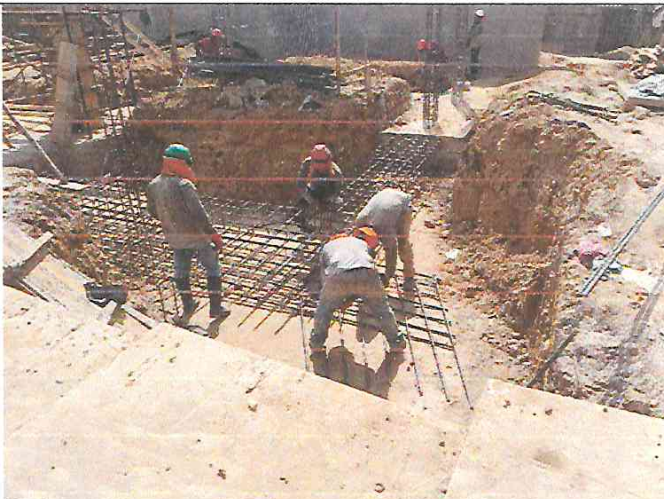
FOTO 28: COLOCACION DE ACERO EN VIGAS DE CIMENTACIÓN, ZAPATAS Y COLUMNAS EN EL CENTRO CULTURAL
