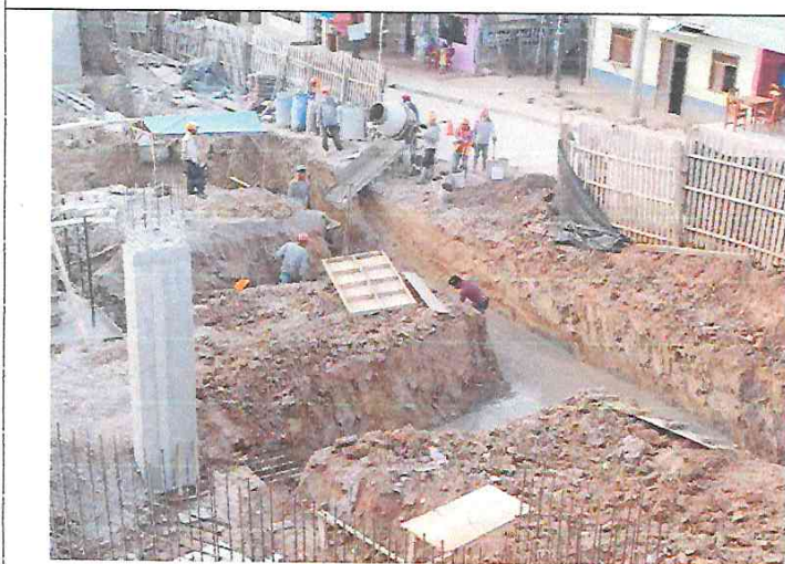
FOTO 23: VACEO DE SOLADO DE ZAPATAS Y VIGA DE CIMENTACION DEL CENTRO CULTURAL
