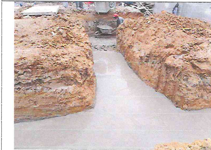
FOTO 22: VACEO DE SOLADO DE ZAPATAS Y VIGA DE CIMENTACION DEL CENTRO CULTURAL
