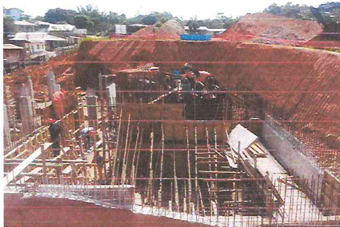
FOTO 19: VACEO DE MURO ARMADO F'C=210 KG/CM2 DEL CENTRO CULTURAL
