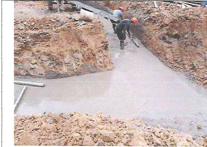
FOTO 21: VACEO DE SOLADO DE ZAPATAS Y VIGA DE CIMENTACION DEL CENTRO CULTURAL
