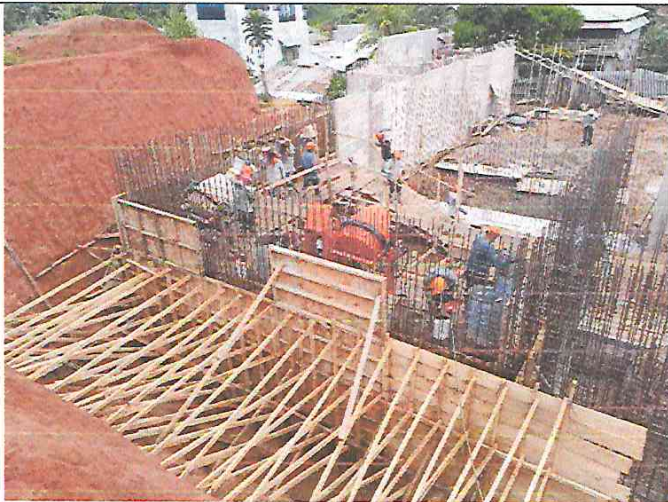
FOTO 14: VACEO DE MURO ARMADO F'C=210 KG/CM2 DEL CENTRO CULTURAL
