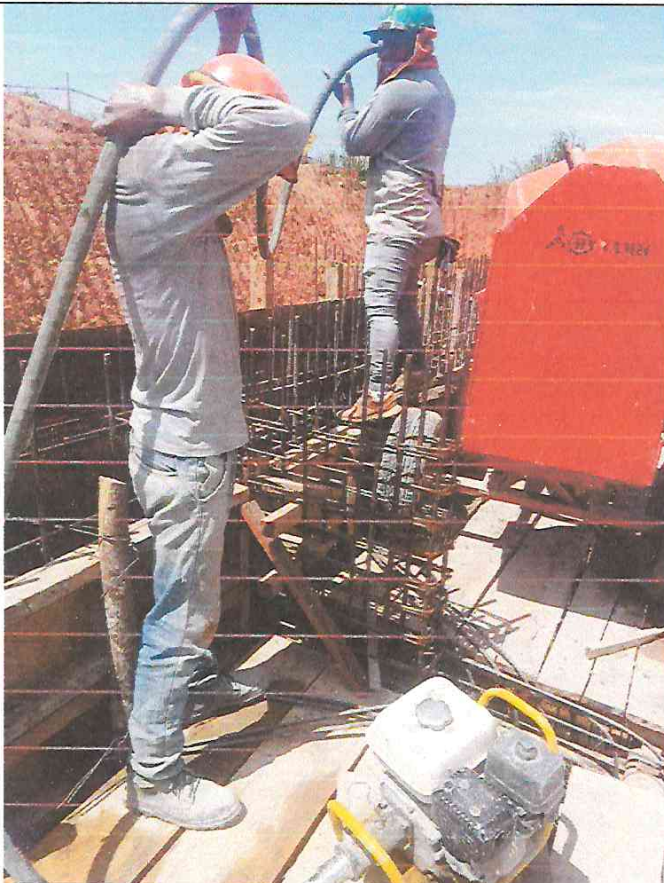
FOTO 17: VACEO DE MURO ARMADO F'C=210 KG/CM2 DEL CENTRO CULTURAL
