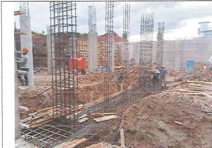
FOTO 27: COLOCACION DE ACERO EN VIGAS DE CIMENTACIÓN, ZAPATAS Y COLUMNAS EN EL CENTRO CULTURAL
