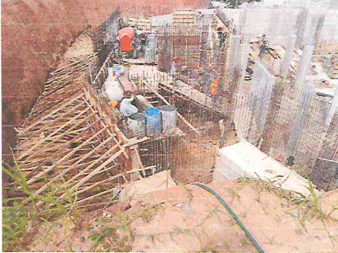
FOTO 16: VACEO DE MURO ARMADO F'C=210 KG/CM2 DEL CENTRO CULTURAL
