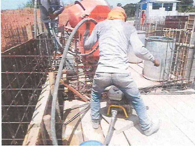
FOTO 18: VACEO DE MURO ARMADO F'C=210 KG/CM2 DEL CENTRO CULTURAL
