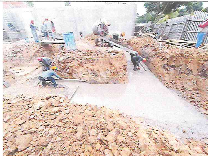
FOTO 20: VACEO DE SOLADO DE ZAPATAS Y VIGA DE CIMENTACION DEL CENTRO CULTURAL
